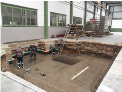
Fundamentarbeit für FPT-Bohrwerk
